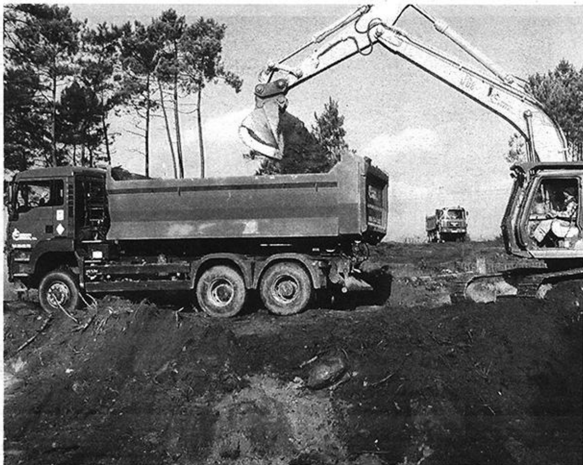
Obras de la ETAP en el municipio de Ponteareas, uno de los grandes proyectos de este municipio.
