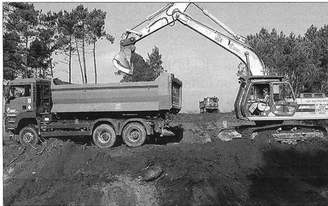
Comienzo del destierre de las obras de la Estación de Tratamiento de Agua Potable. // D.P.
